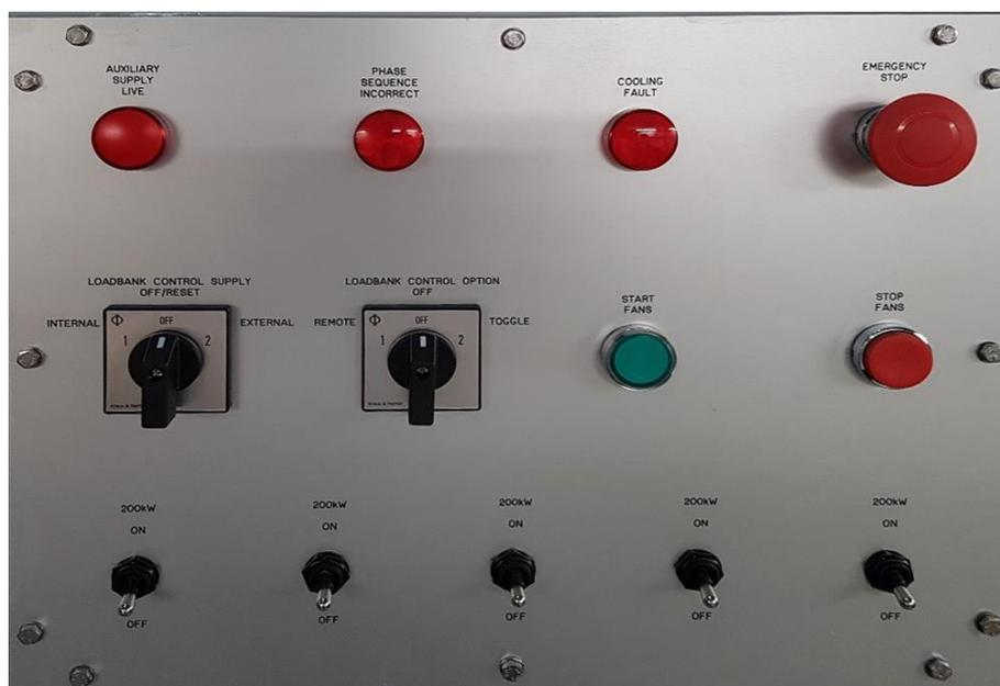
Figure 21 – Va-et-vient, Sélecteur et Bouton-poussoir sur la façade
